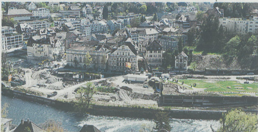
Blick vom Hertenstein auf die Baufelder im Limmatknie: In den kommenden zweieinhalb Jahren entstehen hier ein neues Thermalbad sowie ein neues Ärzte- und Wohnhaus. In das bereits bestehende Verenhof-Geviert kommt eine neue Klinik für Prävention und Rehabilitation. Das Parkhaus rechts im Bild wird in diesen Tagen zurückgebaut.
