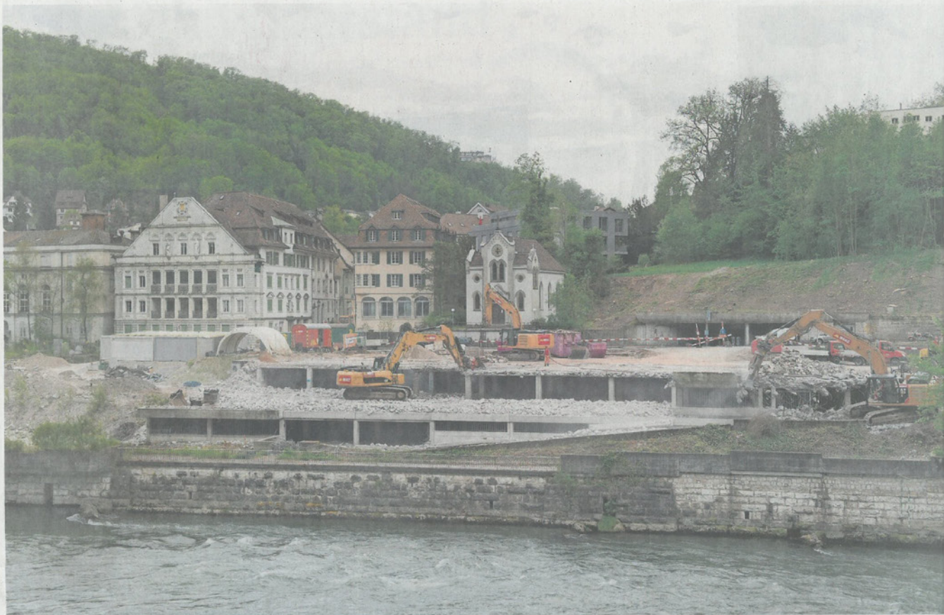
Einst stand hier das Grand Hotel, dann parkierten Autos unter dem Mättelpark: Die Bagger fressen sich seit einer Woche durch den Beton. Die Dreikönigskapelle steht wie ein ruhender Pol mitten im Baulärm.
