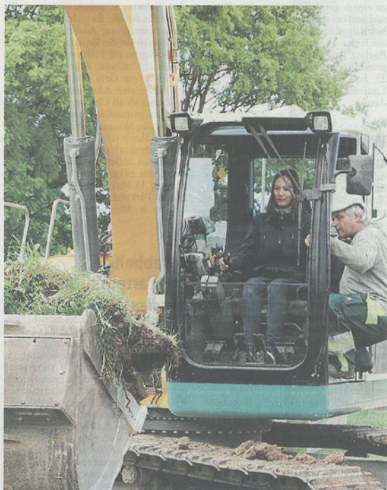
Bauleiterin Jessica Wälti hebt mit dem Raupenbagger ein Loch aus.
