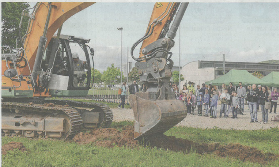
Anstich mit dem Bagger für die neuen Bauten der Schulanlage
