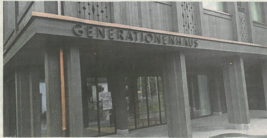
Das Generationenhaus in Bad Zurzach auf dem Höfli-Areal.
