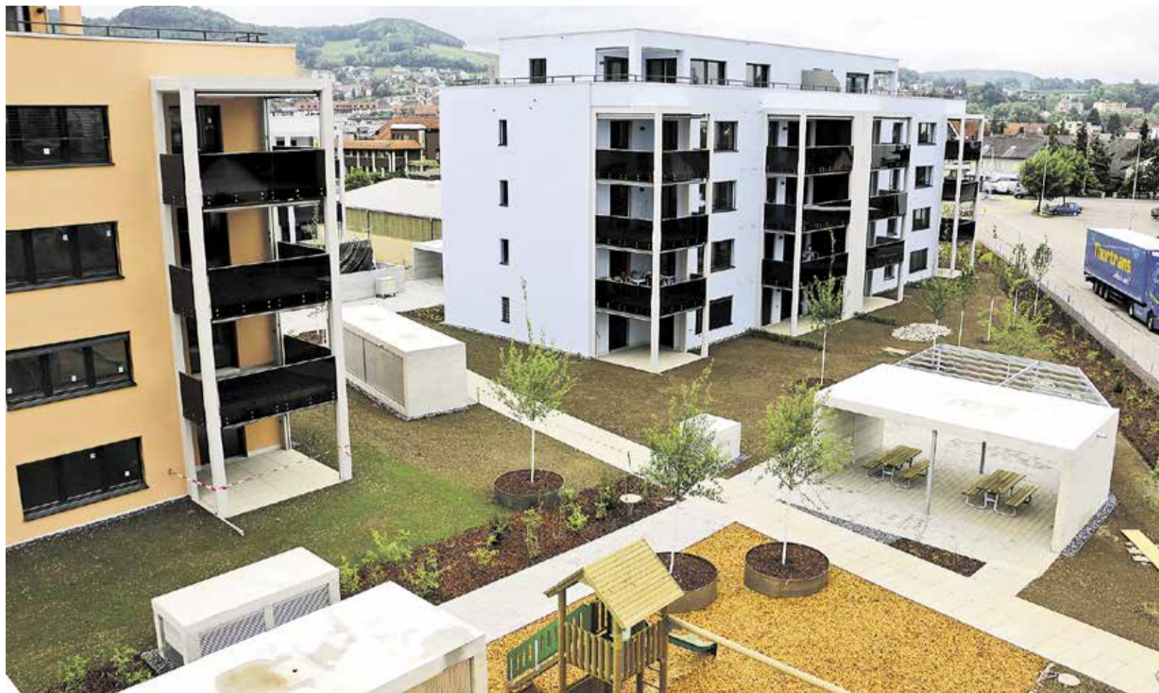
Blick vom Attikageschoss auf den Spielplatz und den Unterstand mit Pergola.
