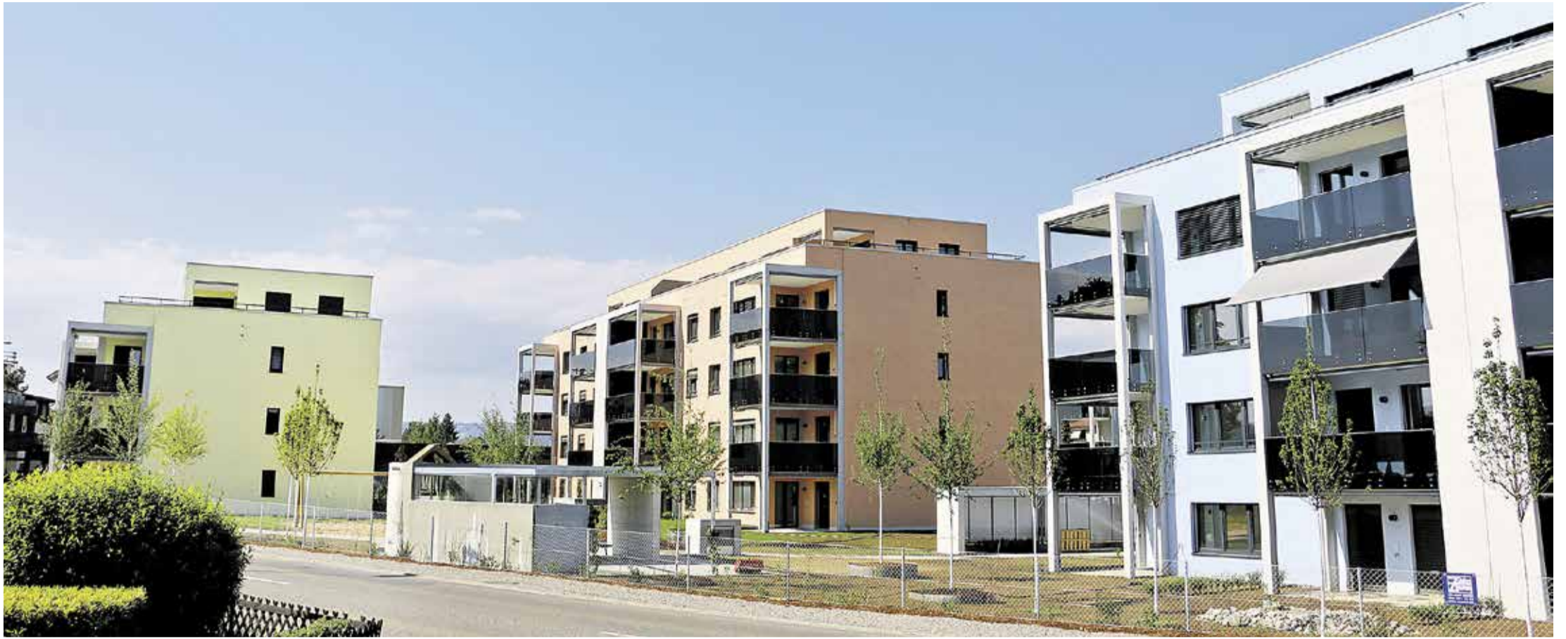
Die in Pastellfarben gestrichene Überbauung von der gegenüberliegenden Seite der Hauptstrasse aus gesehen.
