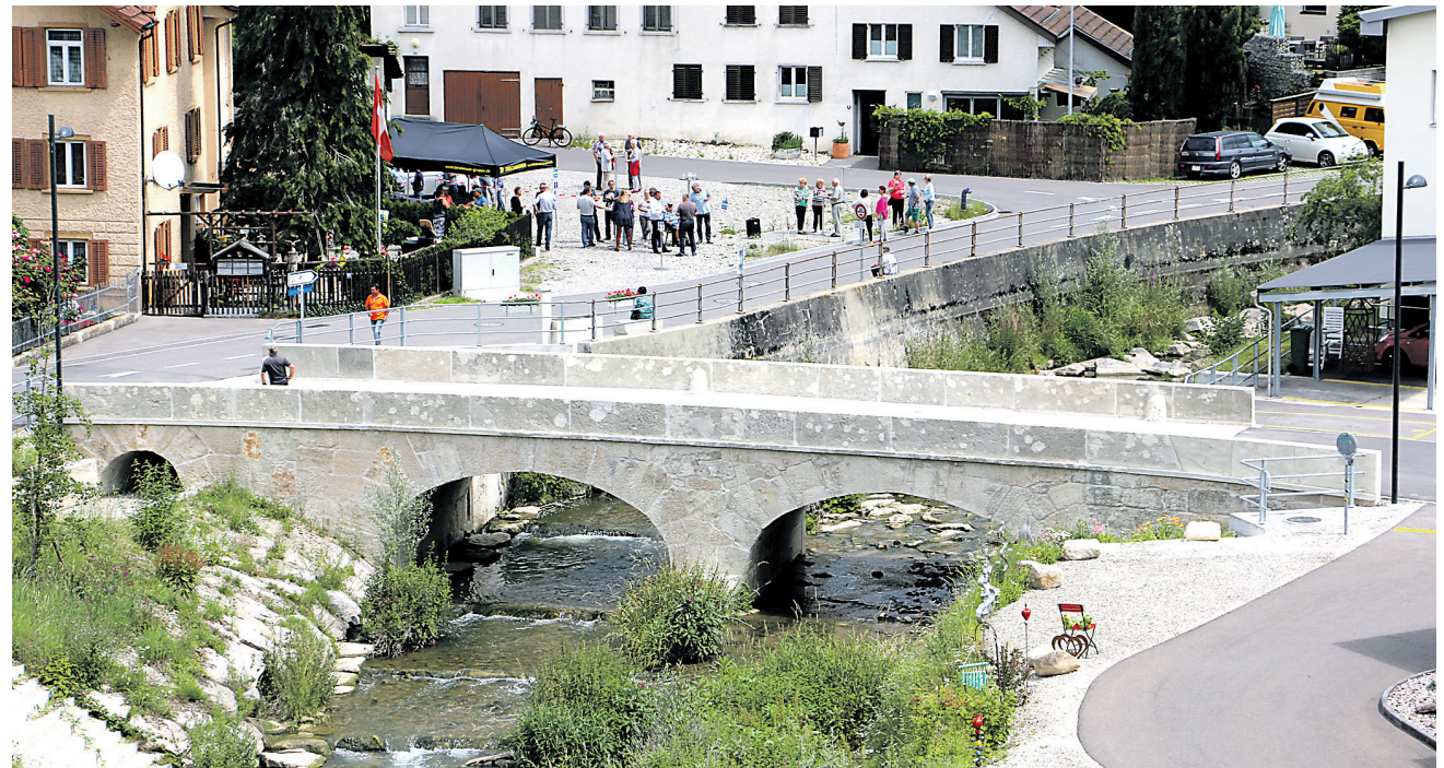
Die sanierte Surbbrücke von der Risstrasse aus gesehen.
