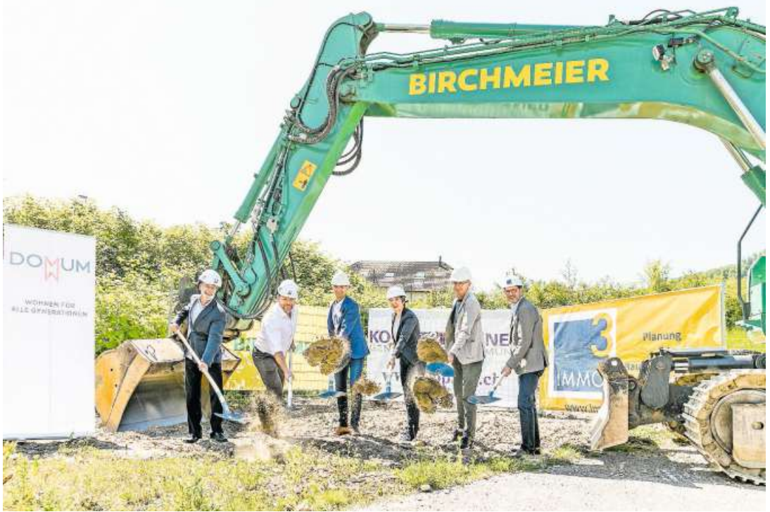
Spatenstich ist erfolgt: In Bad Zurzach entstehen fast 100 neue Mietwohnungen. Bild: Sandra Ardizzone
