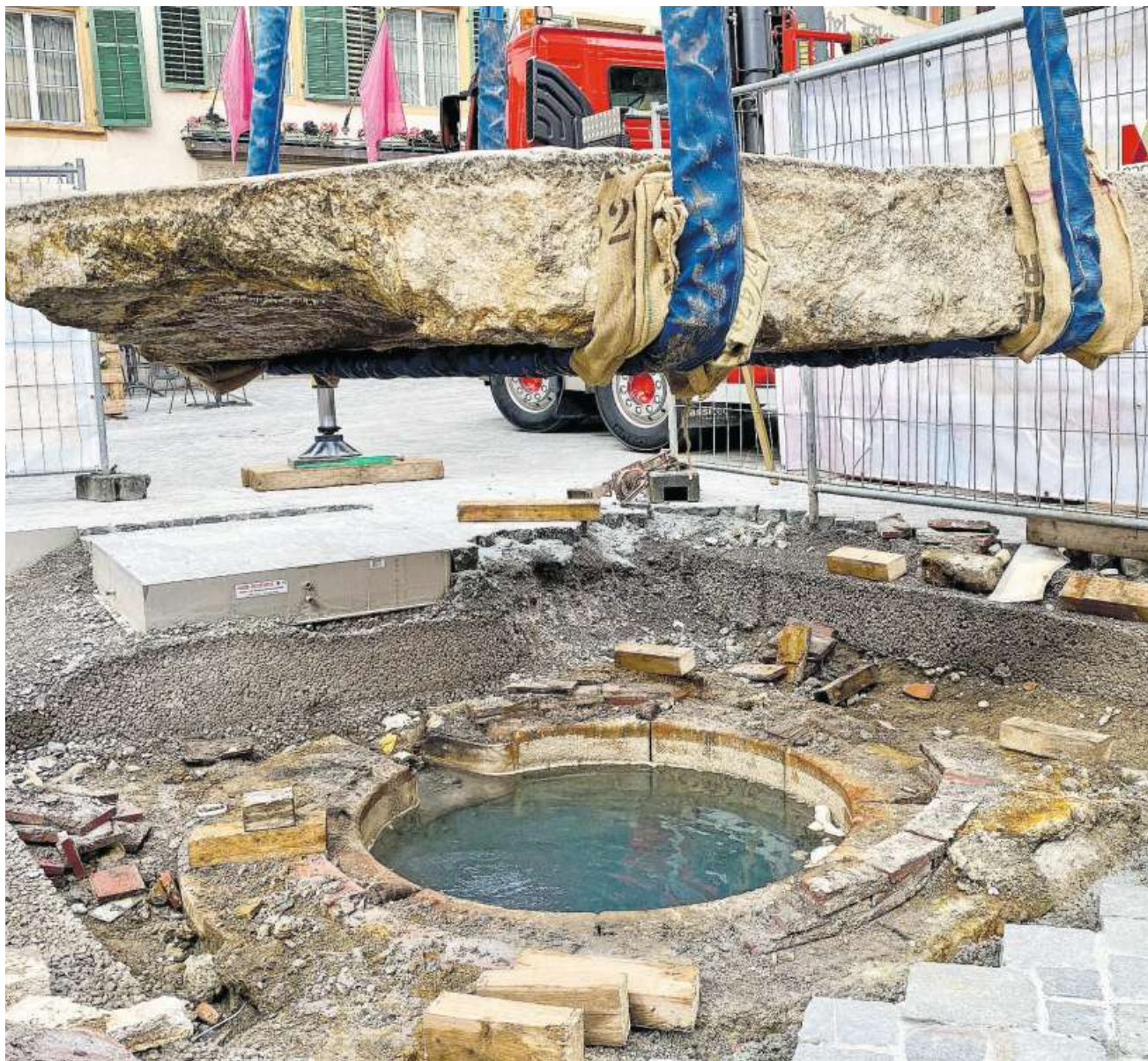
Die Steinplatte, die den Quellschacht seit 600 Jahren verdeckt, wird angehoben. Schon die Römer nutzten diese Quelle.
