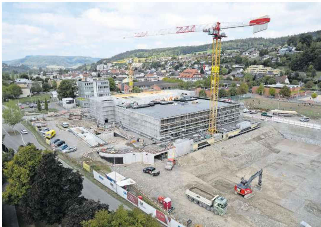
Blick auf die Bauarbeiten im Zentrum Untersiggenthals.
